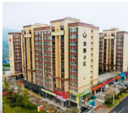
仁怀市苍龙街道易地扶贫安置点凤凰小区
